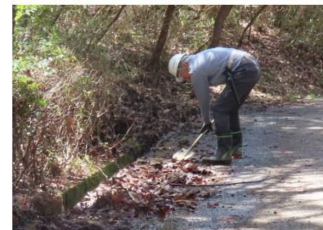
落ち葉がきれいになったら水路に溜まった土砂をとり除く
